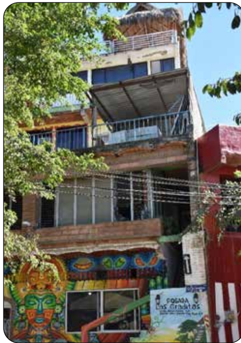
Figura 10.7. Adecuaciones de los hogares a actividades productivas. Fotografía del autor.
